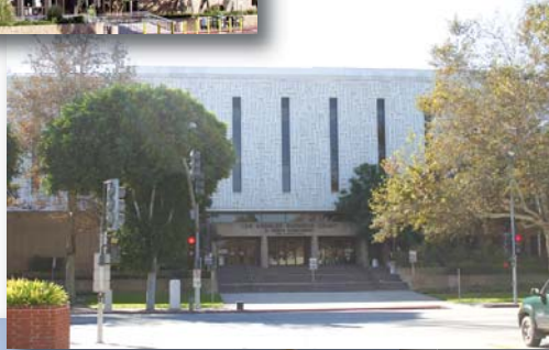
El Monte Courthouse
